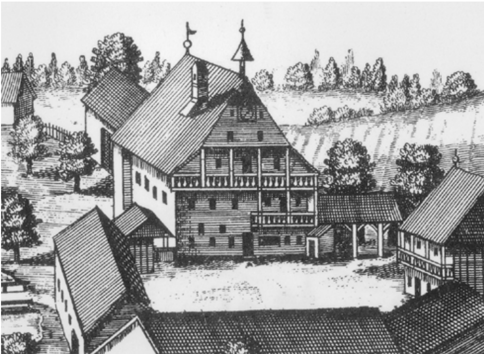
Abb. 2: ... aber selbst noch um 1700 wurden manche Herrenhäuser – wie hier in Erlbach – ganz in Holz aufgeführt.
