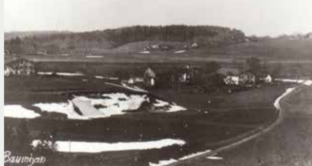
Alte Postkarte von Baumhau, vorne ehem. Kiesgrube ca. 1914
