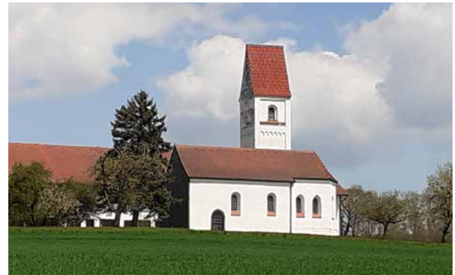
Abb. 14: Sankt Kastulus von Meiletskirchen, wieder eine Eigenkirche geworden.
